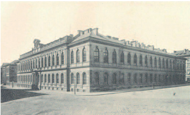
Obr. 5. Chemický ústav Německé Karlo-Ferdinandovy univerzity v Praze, čp. 478, Praha 2, Nové Město, U nemocnice 5, Lípová, Salmovská 1 a 3; sídlo děkanátu Lékařské fakulty Německé Karlo-Ferdinandovy univerzity; pohled z křižovatky ulic U nemocnice a Lípové koncem 19. století (Die deutsche Karl-Ferdinands-Universität in Prag unter der Regierung Seiner Majestät des Kaisers Franz Josef I. Prag: Verlag der J. G. Calve'schen k. u. k. Hof- u. Universitätsbuchhandlung (Josef Koch); 1899)
